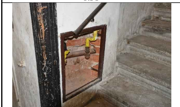
schodiště v 1.NP
