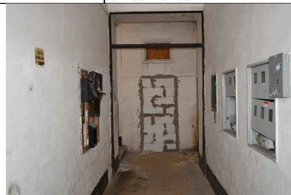
1.NP – vstupní chodba
