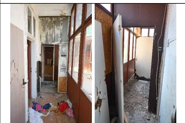
chodby v domě
